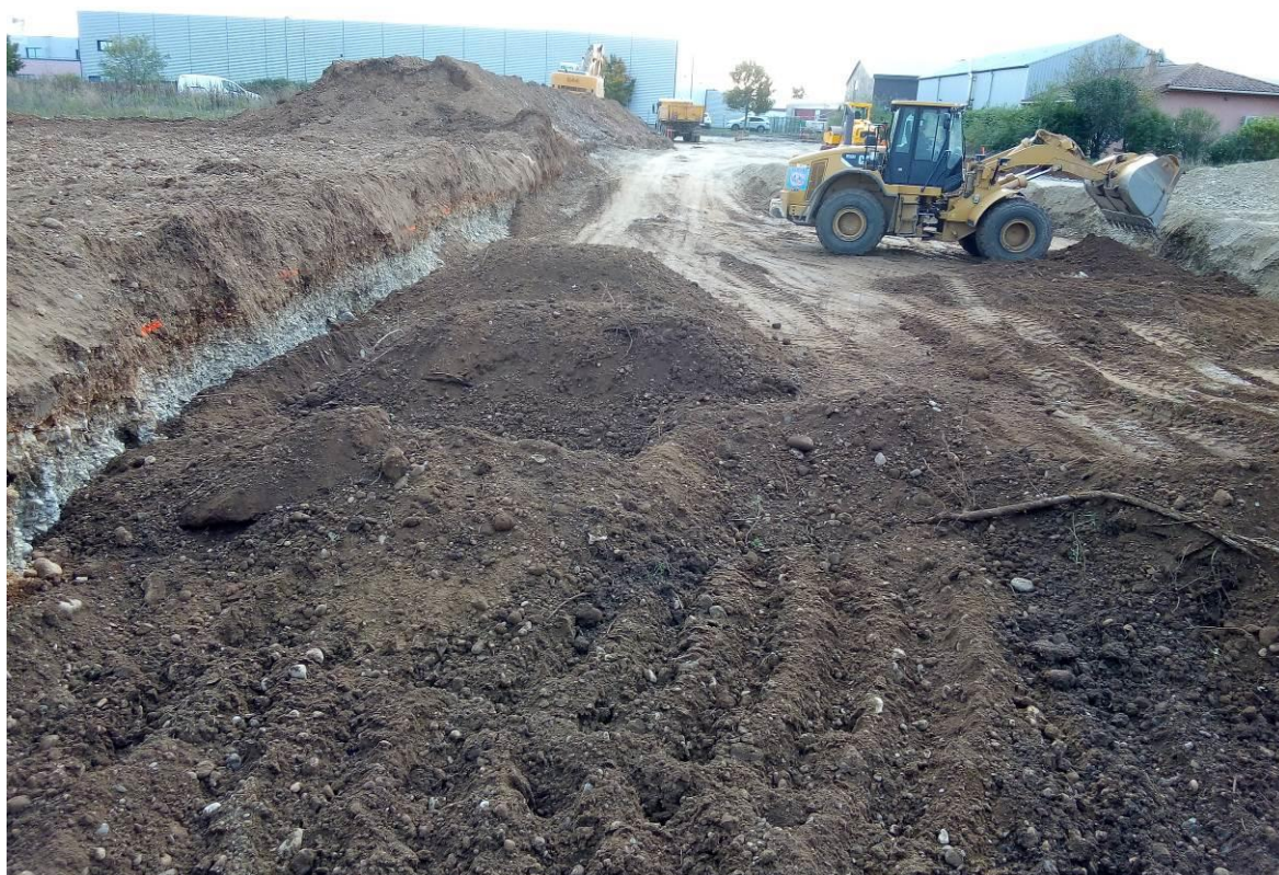
Emprunt et substitution par remblai de qualité médiocre le jour de notre intervention
