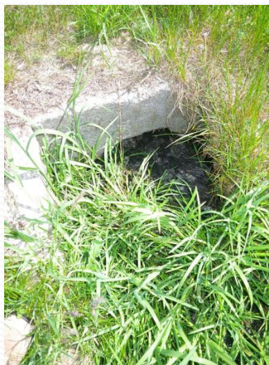
Obstruction d'une buse Ø300 au lieu dit « Chez Grégoire »
