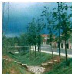
Noues cloisonnées, Parc Bouglione, Corbas
