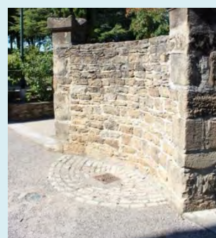
Exemple: pavés jointoyés au sable (sol perméable) et stabilisé (Chabrilan, Drôme)
