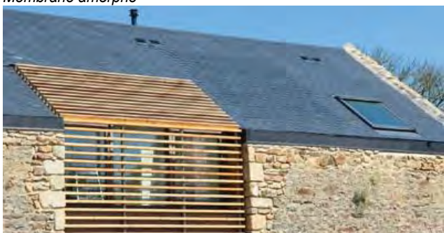
panneau solaire thermique Thermoslate invisible (sous ardoises)
