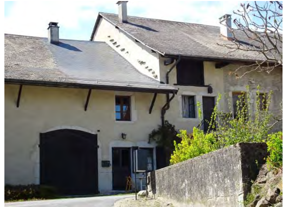
Passées de toit reposant sur des consoles, toit pour partie ardoises artificielles pour partie ardoises naturelles
