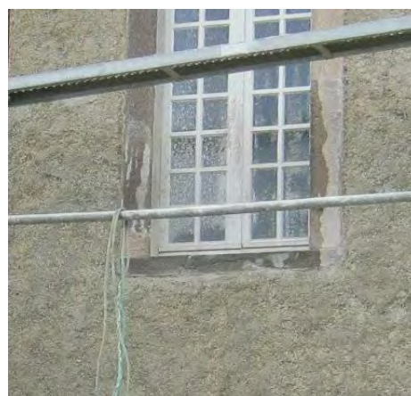
OUI- enduit isolant remplaçant l'enduit existant
