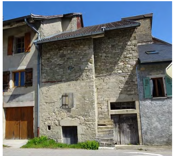
Rue du Centre, mur ancien, en pierres. Si les pierres apparaissent c'est que l'enduit est usé.
