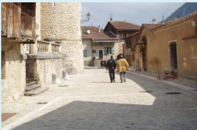
Exemple: pavés jointoyés au sable (sol perméable) et stabilisé (Chabrilan, Drôme)
