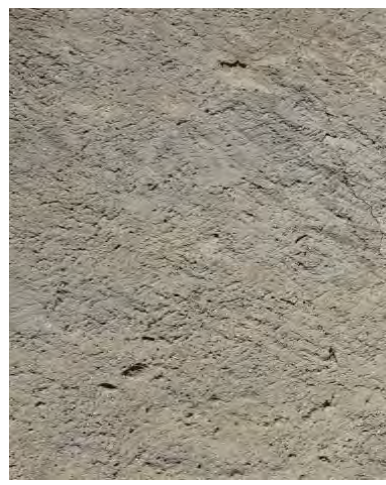
Chaux naturelle - Enduit couvrant
