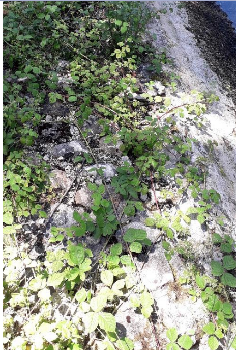
Figure 5: Enrochement fin avec jointoiement dégradé disposé sur la crête du déversoir
