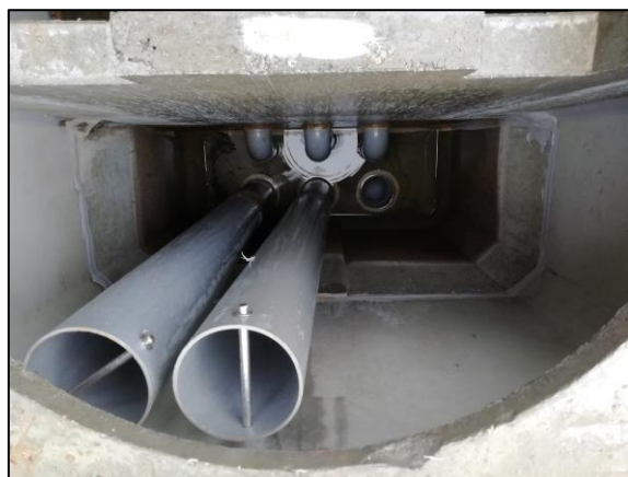
Photo 3 : Vue intérieure de la chasse à eaux brutes
