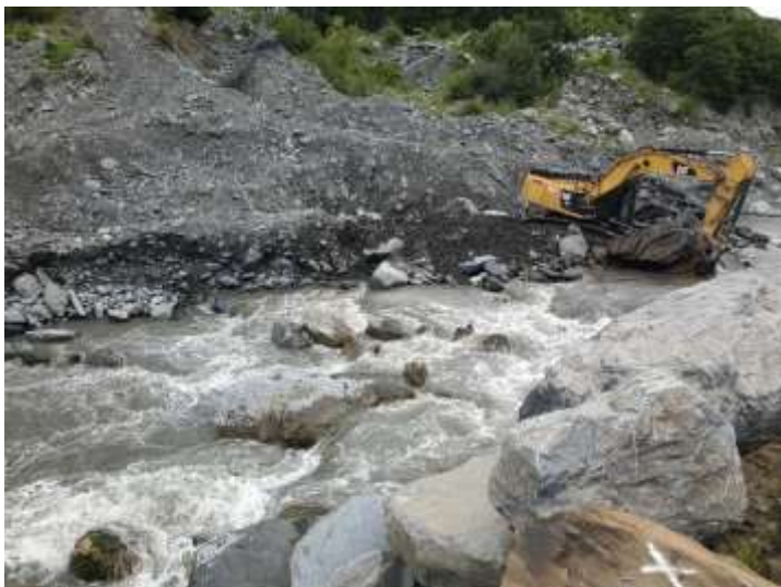
Figure 13 : Prélèvement de blocs à la confluence avec le Poucet suite à une lave torrentielle en juin 2020
