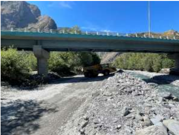
Figure 21 : Lit curé en rive droite, batardeau constitué en rive gauche et piste créée à l'arrière du batardeau (travaux de curage de l'Arc par le SPM en 2022)
