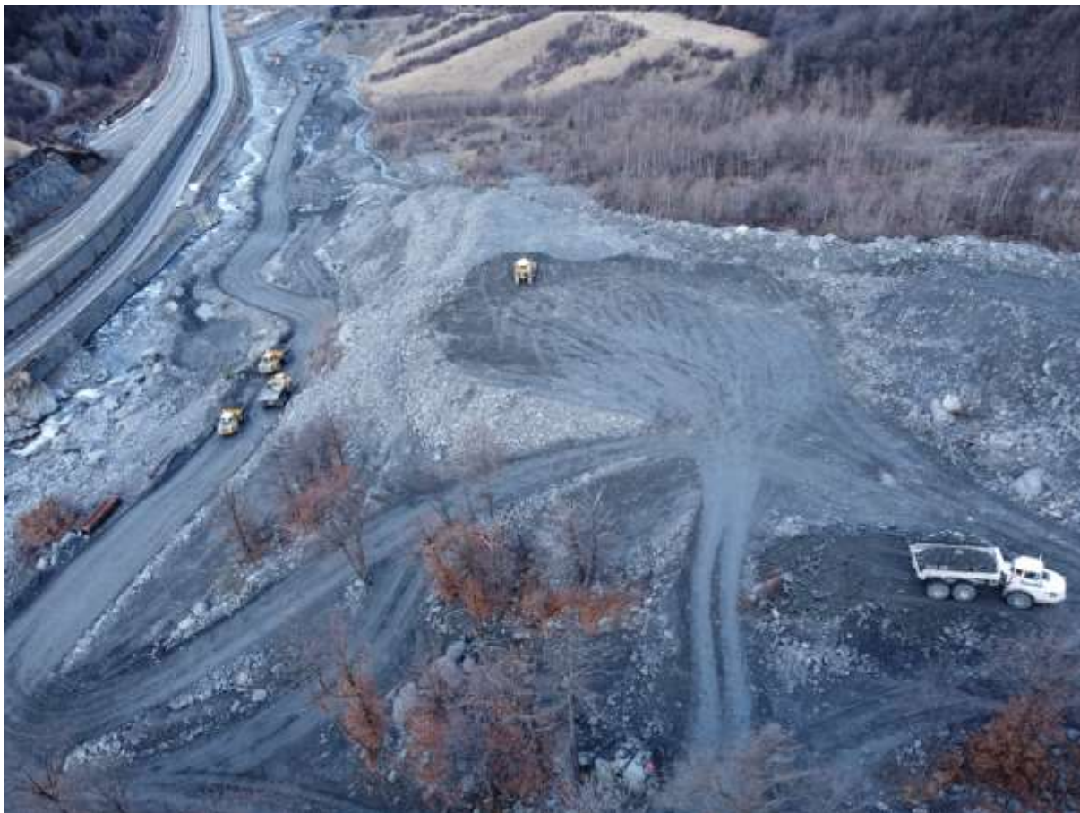
Figure 16 : Chantier de curage de la confluence en 2024, vue sur la plate forme de criblage concassage située sur le cône
