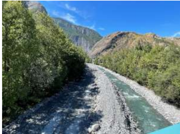
Figure 21 : Lit curé en rive droite, batardeau constitué en rive gauche et piste créée à l'arrière du batardeau (travaux de curage de l'Arc par le SPM en 2022)
