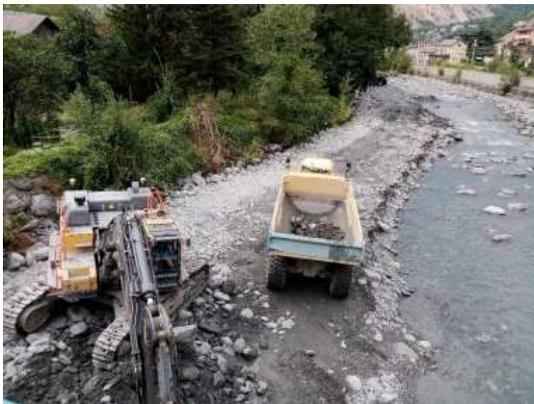
Figure 22 : Batardeau et piste retirés à l'avancement, de l'amont vers l'aval, et curage de la rive gauche (travaux de curage de l'Arc par le SPM en 2022)
