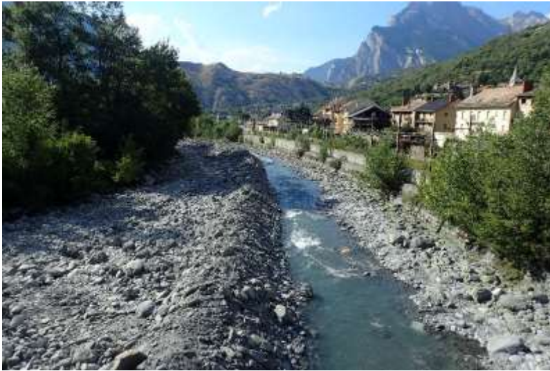
Figure 20 : Lit curé en rive droite et batardeau constitué en rive gauche (travaux de curage de l'Arc par le SPM en 2022)
