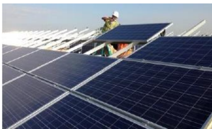
Figure 21 – Photographie pose des panneaux sur les supports
