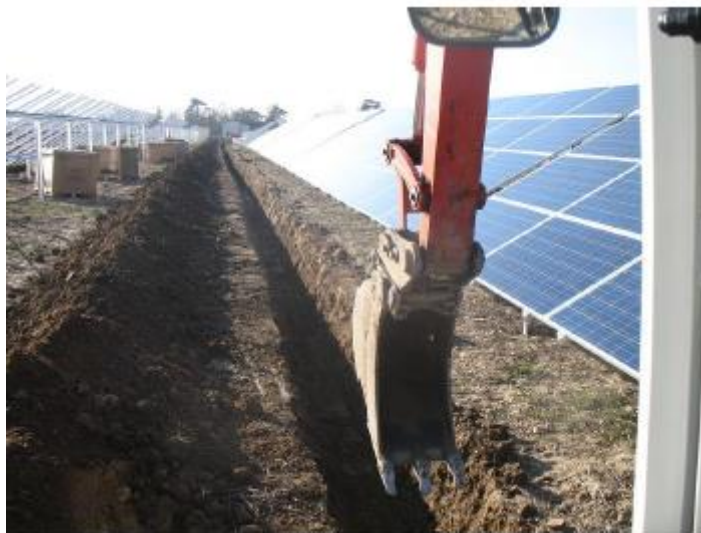
Figure 22 – Tranchée pour le passage des câbles
