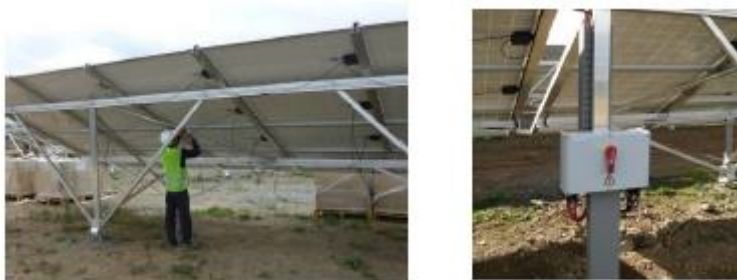
Figure 23 – Photographies du câblage des panneaux (gauche) et du boîtier de raccordement (à droite)
