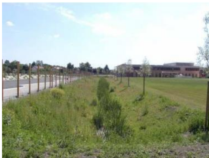
Figure 34 : Exemple d'une noue
