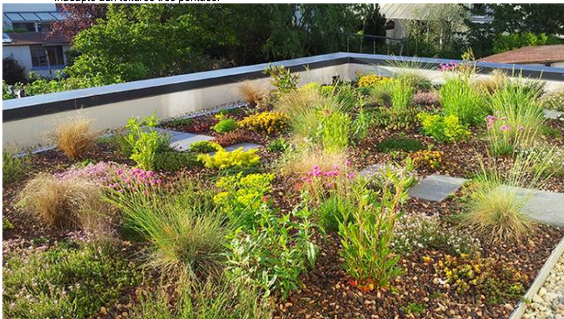
Figure 36 : Exemple d'une toiture terrasse végétalisée
