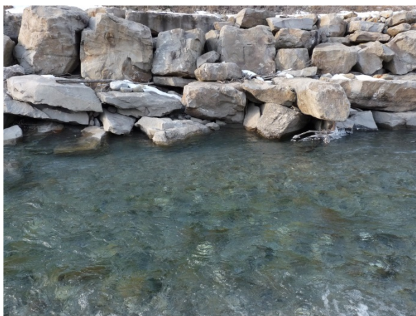
Figure 6-5 : Exemple d'agencement de blocs avec anfractuosités submergées
