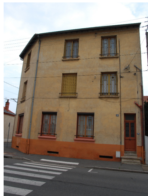
Exemple d'un édifice pouvant supporter une isolation par l'extérieur : pas de modénature et présence d'un recul par rapport aux façades latérales.
