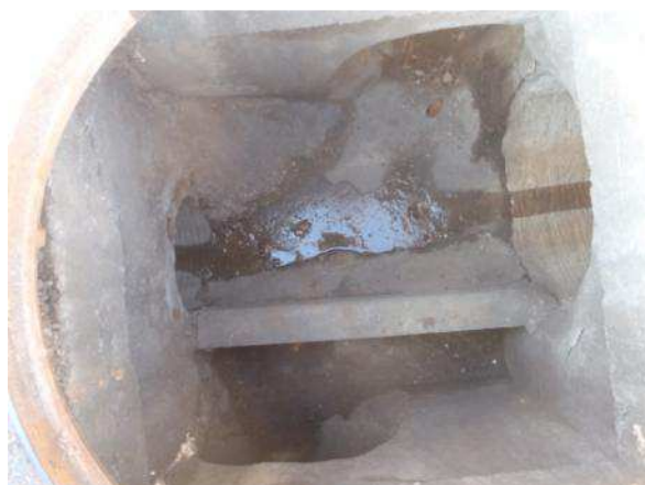
Délestage intra réseaux eaux pluviales (Route de Romans - Regard n°20)
