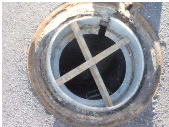
Regard 103 (Chemin du Grobon – EP) - Oubli de matériaux de construction
