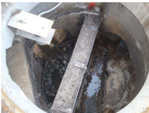
Station d'épuration – Autosurveillance en place sur DO
