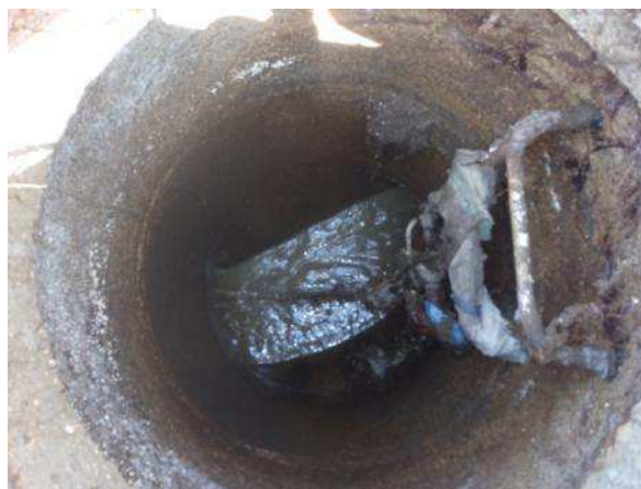
Regard 23 (Les Payes – U) - Traces de mise en charge
