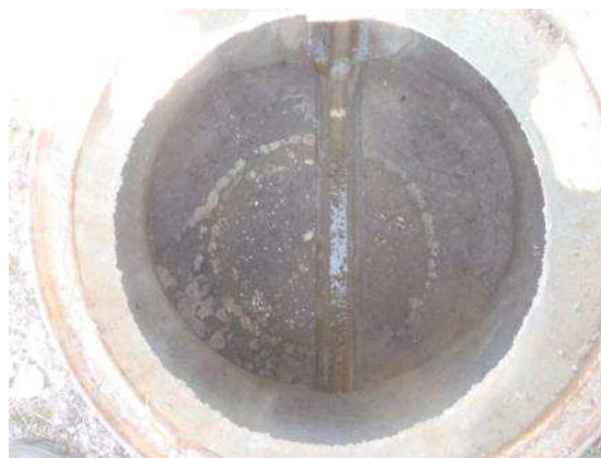
Regard 139 (Proche de l'Avenue du Maréchal Foch) – Réduction de section 400 mm -> 160 mm
