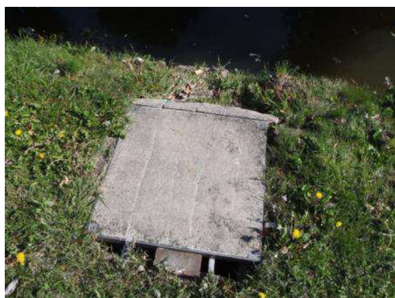
Parc du Clos Janin (R584) – Cadre hors service, affaissement
