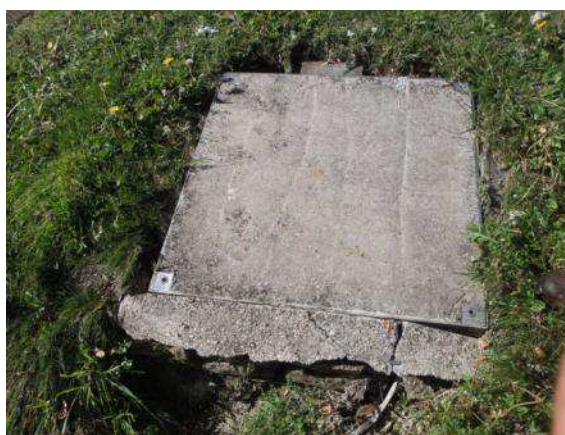
Parc du Clos Janin (R584) – Cadre hors service, affaissement
