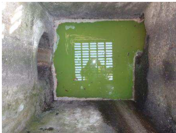
DO 78 (Route de la Tredonnière - U) - Eaux stagnantes avec odeur forte de javel (la coloration est due à la fluorescéine injectée dans le réseau)
