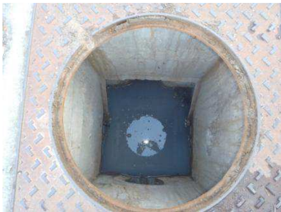
Regard 123 (Lotissement Caluire – EP) – Rejet eaux usées vers eaux pluviales
