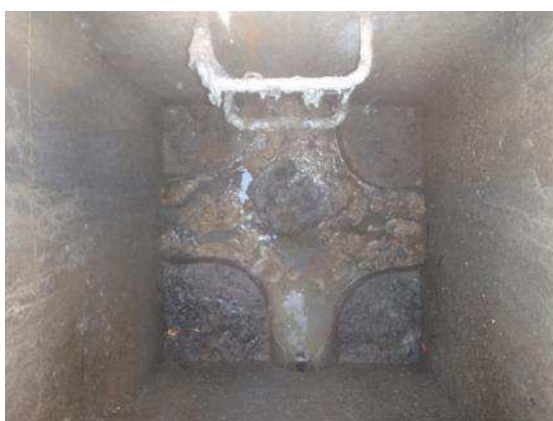
Regard 88 (Rue Pasteur – U) – Traces de mises en charges
