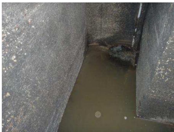
DO 10 (Le Colombier - U) – Canalisation amont et aval totalement en charge
