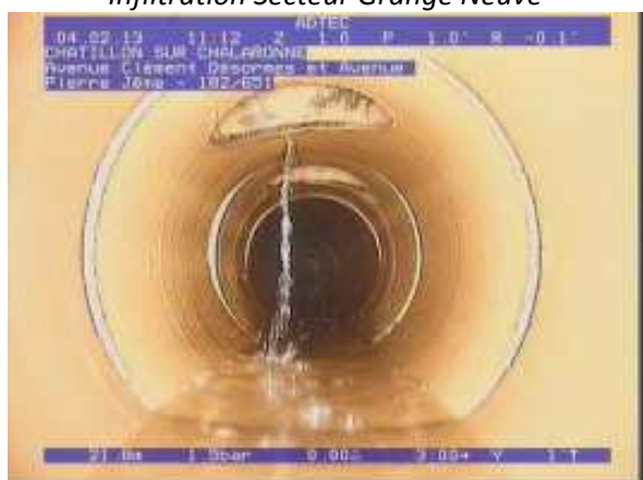
Infiltration par branchement ? (Place du Champ de Foire)
