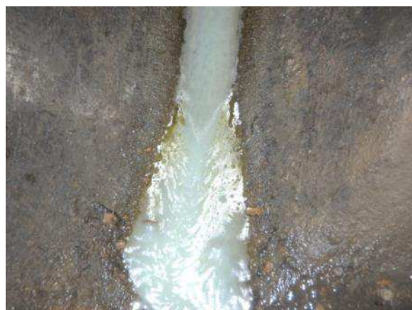
Regard 9 (Rue Pierre et Marie Curie – EP) - Effluent suspect au sein du réseau d'eaux pluviales
