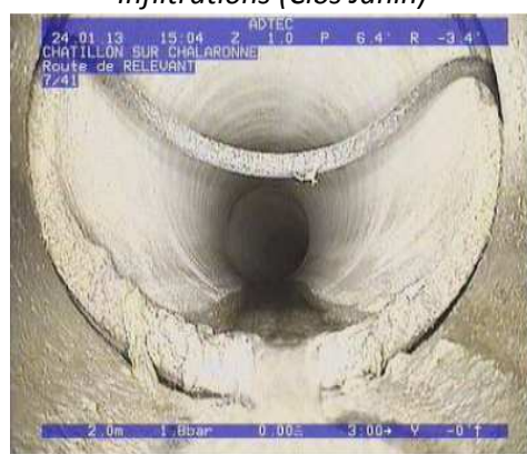
Joint d'étanchéité défectueux (Rte de Relevant)
