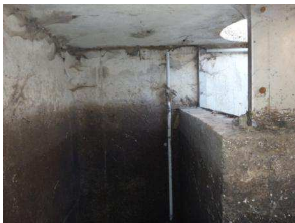
Traces de mises en charge dans le DO 10 (Le Colombier - U)
