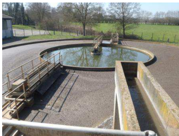
STEP Bourg – Bassin d'aération avec injection de chlorure ferrique (traitement phosphore) et décanteur secondaire
