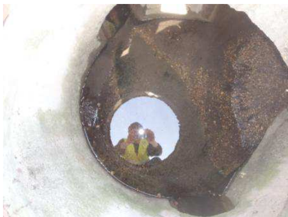
Regard 209 (Collège et Lycée) – Réduction de section 300 mm + 700 mm -> 300 mm
