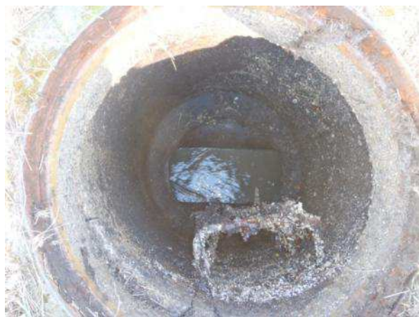
Regard 21 (Les Payes – U) - Traces de mise en charge
