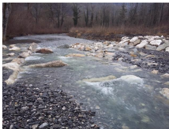
Figure 89 : Illustration d'un seuil franchissable, d'une pente de 5% sur le Saint-Ruph (74, HYDRETTES 2017)
