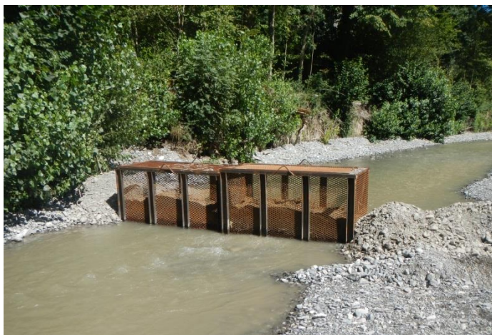
Figure 87 : Exemple d'un barrage filtrant composé de paille permettant une décantation primaire amont (HYDRETTUES, Saint Ruph 74, 09/2015)
