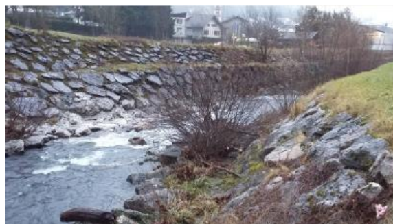
Photo 2 : Ouvrage de contention, digue et seuil de stabilisation sur le Nom
