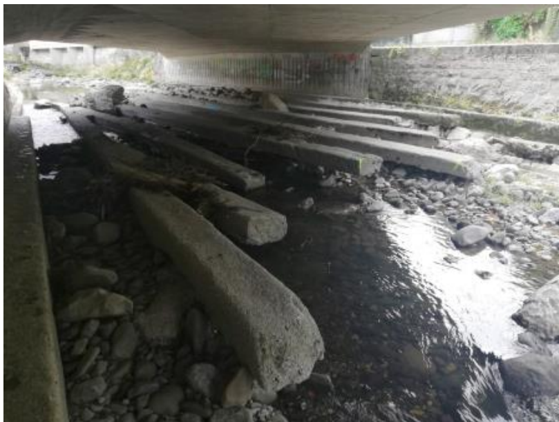
Photo 10 : Détail des longrines béton sous le Pont Neuf
