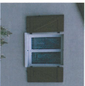
Fig 16. Volets bois à lames croisées à écharpe
