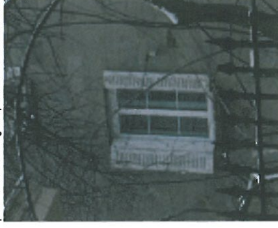
Fig. 9. 3 carreaux (de même dimension) par vantail
