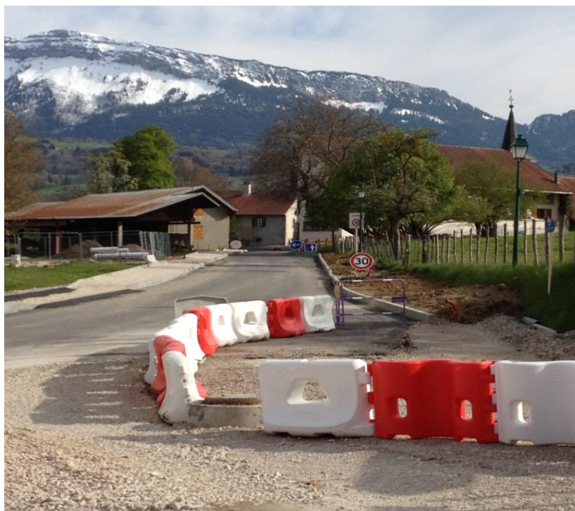
Travaux d'installation du dôme franchissable provisoire en lieu et place du carrefour giratoire
