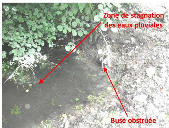
Buse obstruée provoquant une zone de stagnation en amont – Hameau « Saint-Jean » - Chemin de l'Ancienne Chapelle
