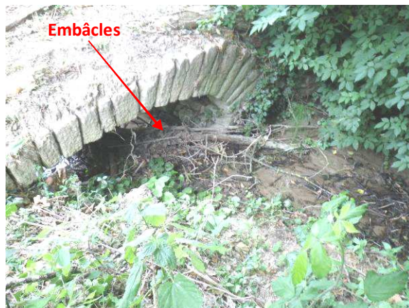
Embâcles en amont de l'arche – Montée de Serran – Hameau « Serran »
