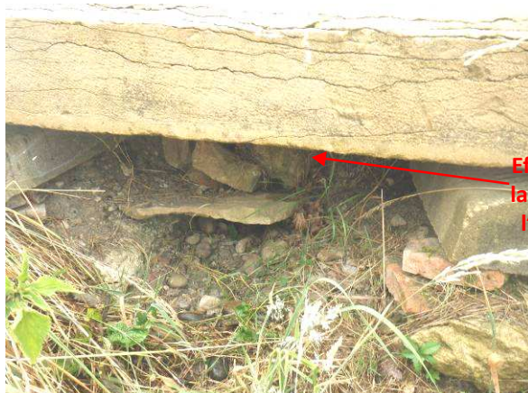
Effondrement partiel d'une conduite – Rue de la Croix Goyet
