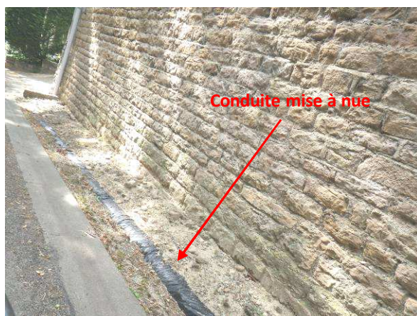
Conduite d'eaux usées mise à nue – Hameau « Flurieux » - Chemin des Juifs
