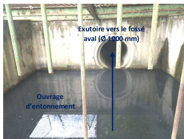
Débordement de l'ouvrage d'entonnement au droit de la ruelle de la Genardière
