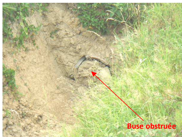
Buse obstruée – Chemin communal C4 à proximité de la RD 75d
