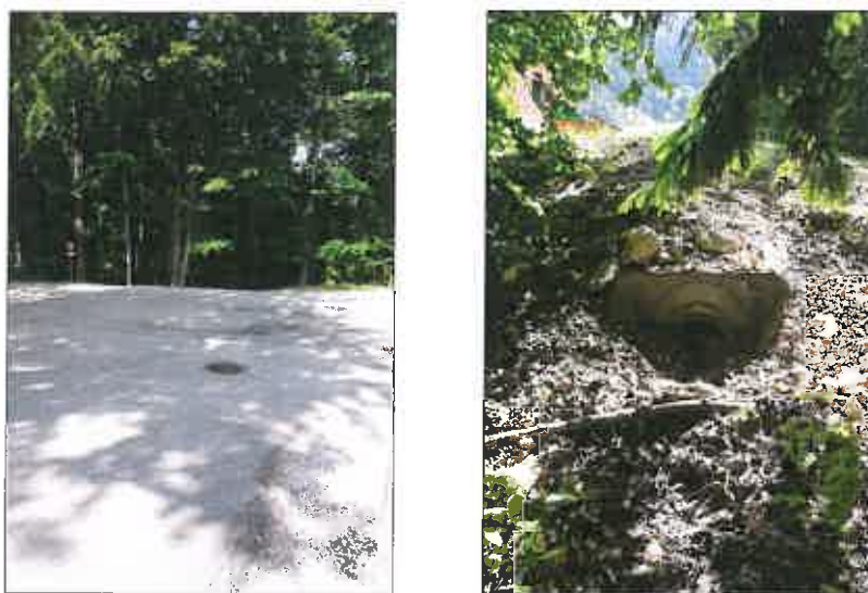
Fig. 6-d : Présentation la grille de collecte des eaux de ruissellement de la zone artisanale
