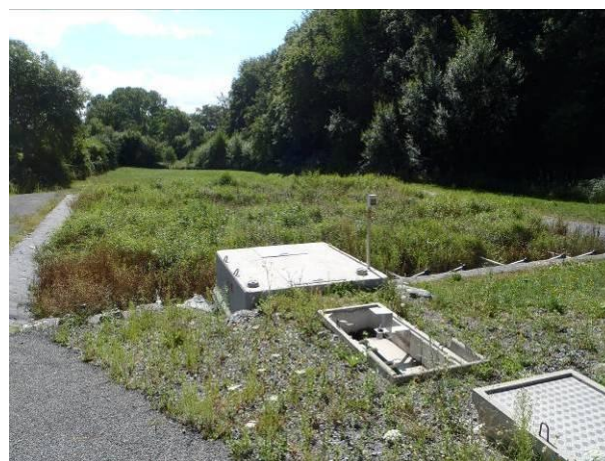
Canal de comptage et filtre planté de roseaux
