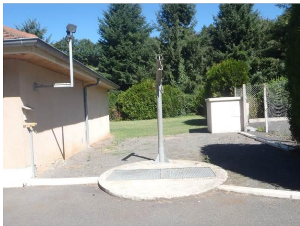
Poste de relevage en entrée de station
