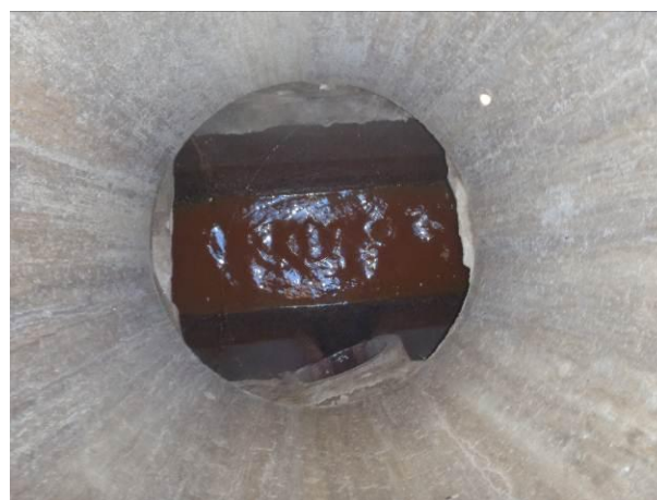
Effluents atypiques (La Gare , RV n°51) - Il s'agit de résidus de chlorure ferrique -
