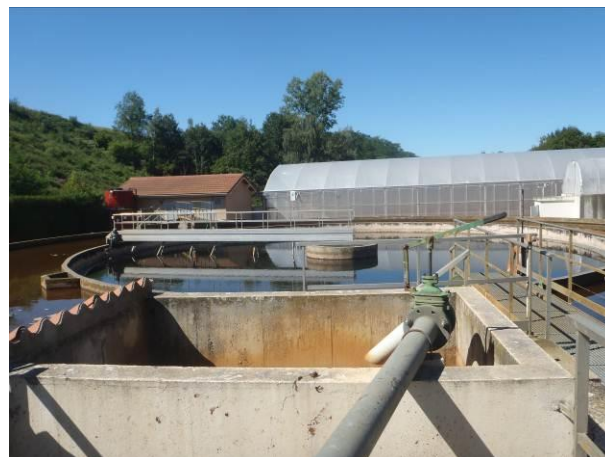
Prétraitement, boues activées et clarificateur
