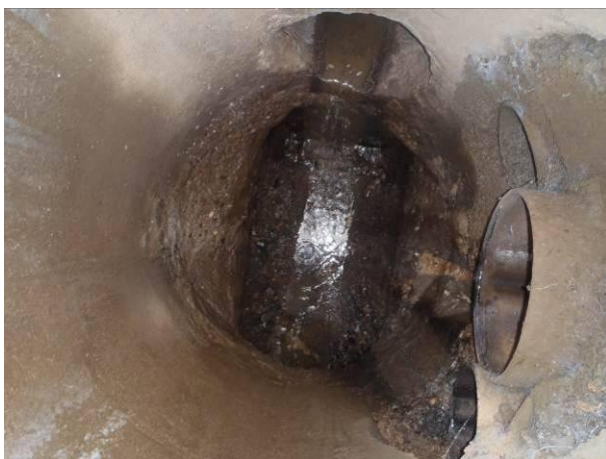
Regard vétuste : radier dégradé et abrasé, branchements défectueux (La Gare , RV n°105)
