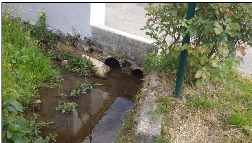
Rejet du réseau eaux pluviales dans le ruisseau des Feugères
