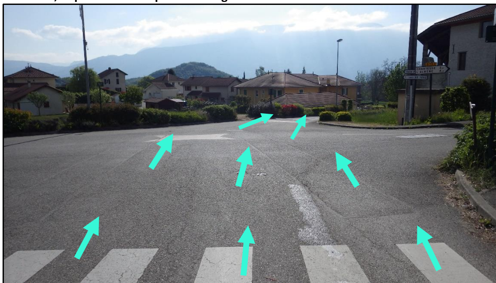
Carrefour, dépourvue de dispositifs d'engouffrements
