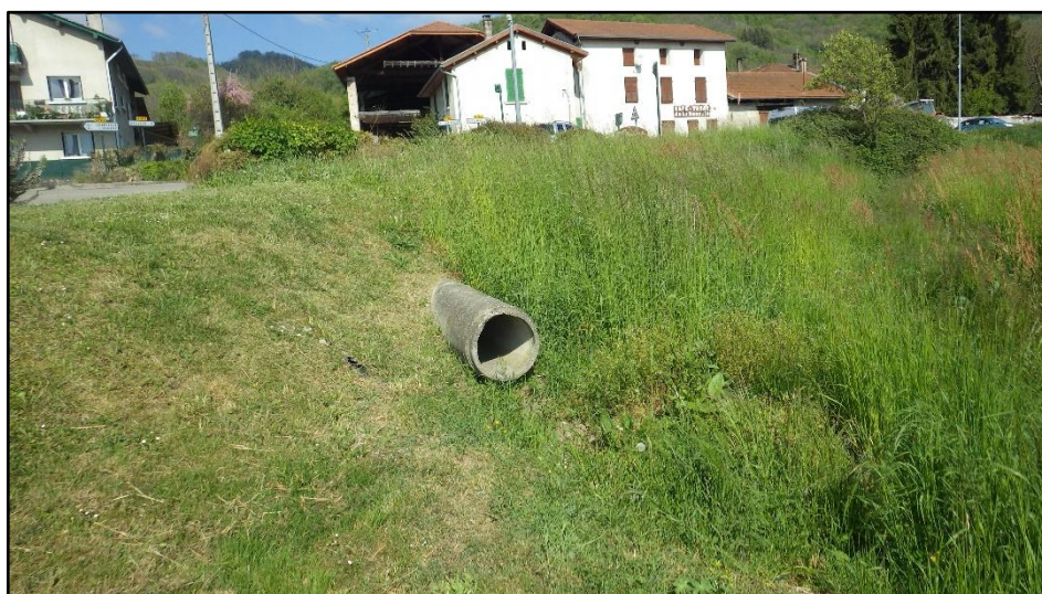
Rejet dans le fossé en contrebas, de la canalisation qui collecte les deux grilles
