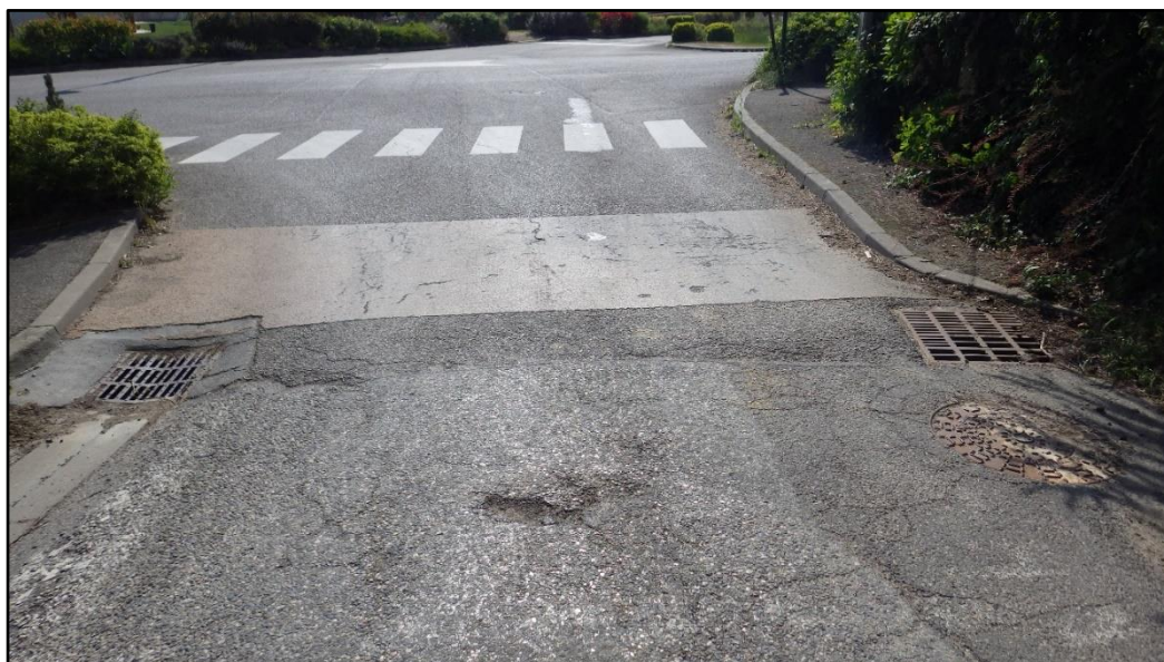
Carrefour, dépourvue de dispositifs d'engouffrements
