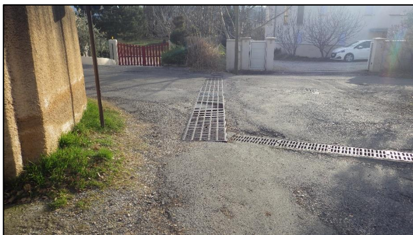
Dispositif de collecte en travers
