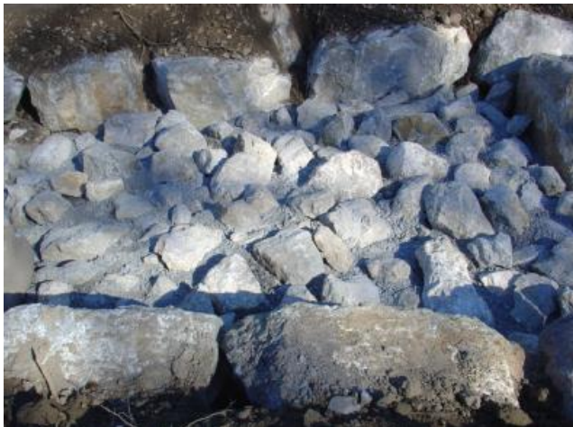
Photo 1 : Exemple de macro rugosité et agencement de blocs
