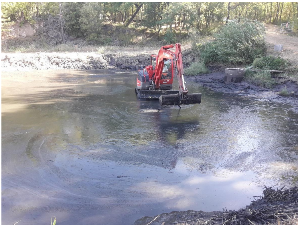
Figure 3 Photo AE: Les boues sont ramenées vers la pompe à l'aide d'une minipelle munie d'un madrier
