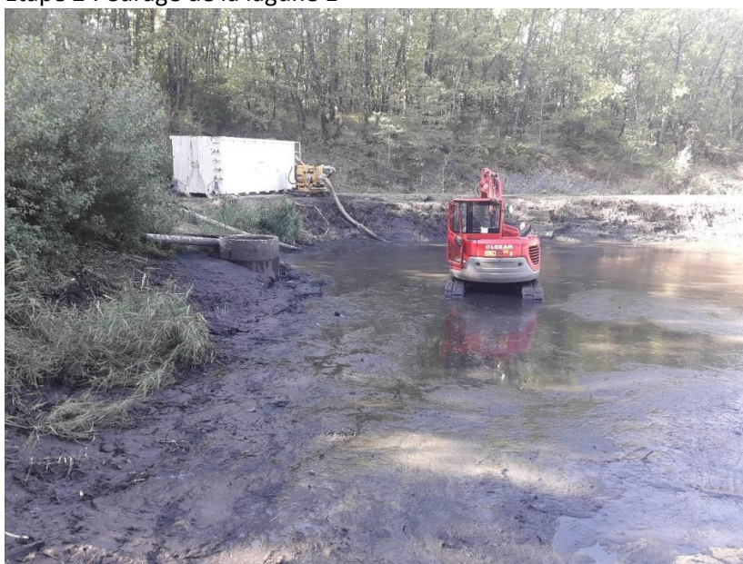
Figure 2 Photo AE: Transfert des boues depuis la lagune dans un caisson étanche
