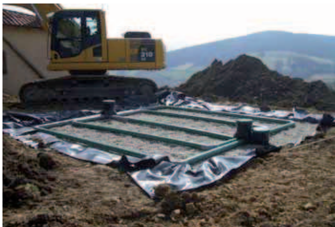
Travaux de réalisation d'un filtre à sable
