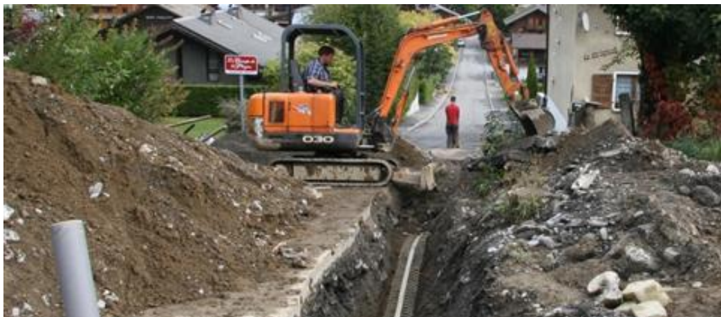
Travaux de réfection de la voirie et de la chaussée, de réalisation des réseaux d'eaux pluviales et d'enfouissement des réseaux d'électricité et de téléphone Taille de Mas des Champs de la Plagne octobre 2012
