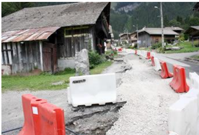
Travaux de réfection de la voirie et de la chaussée, de réalisation des réseaux d'eaux pluviales et d'enfouissement des réseaux d'électricité et de téléphone aux Prodains, été 2009
