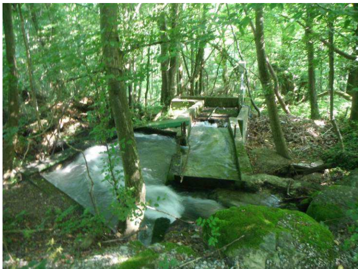
La prise d'eau « Doris » et la chambre de mise en charge
