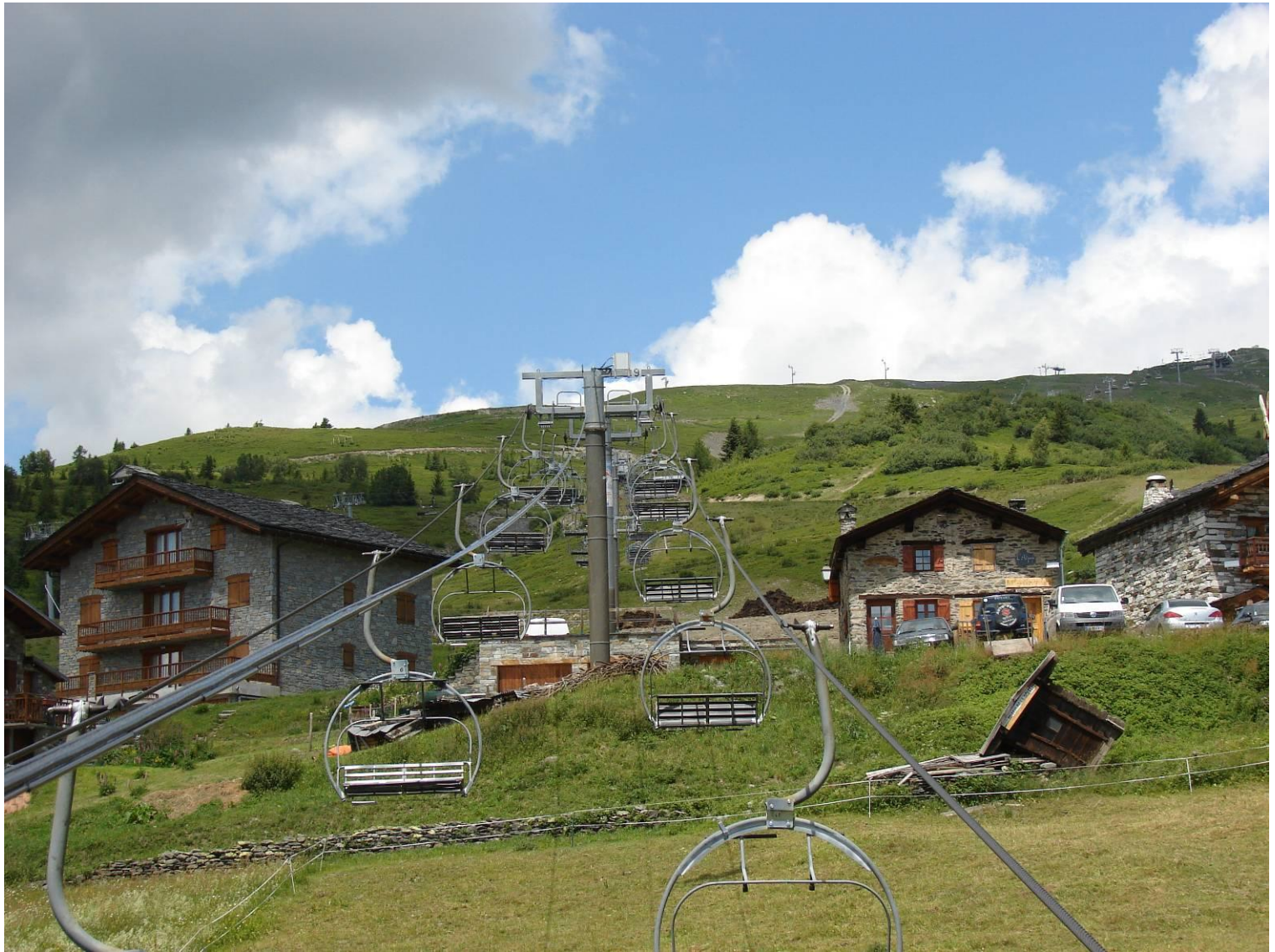
Photographie 3 : Implantation actuelle ne permettant pas de garantir les gabarits de passage et la protection incendie
