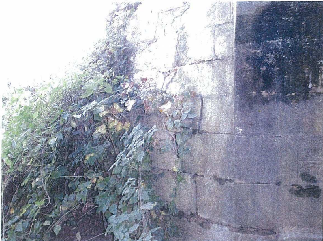
Ph.15 Mur en aile aval R.D. fissure verticale
