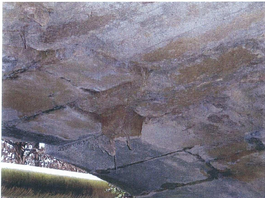
Ph.31 Extrusion d'un moellon sous voûte côté amont
