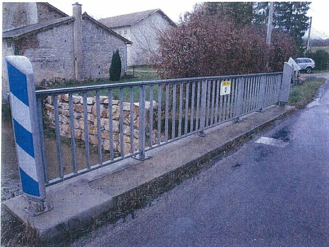
Ph.35 Trottoir et garde corps amont
