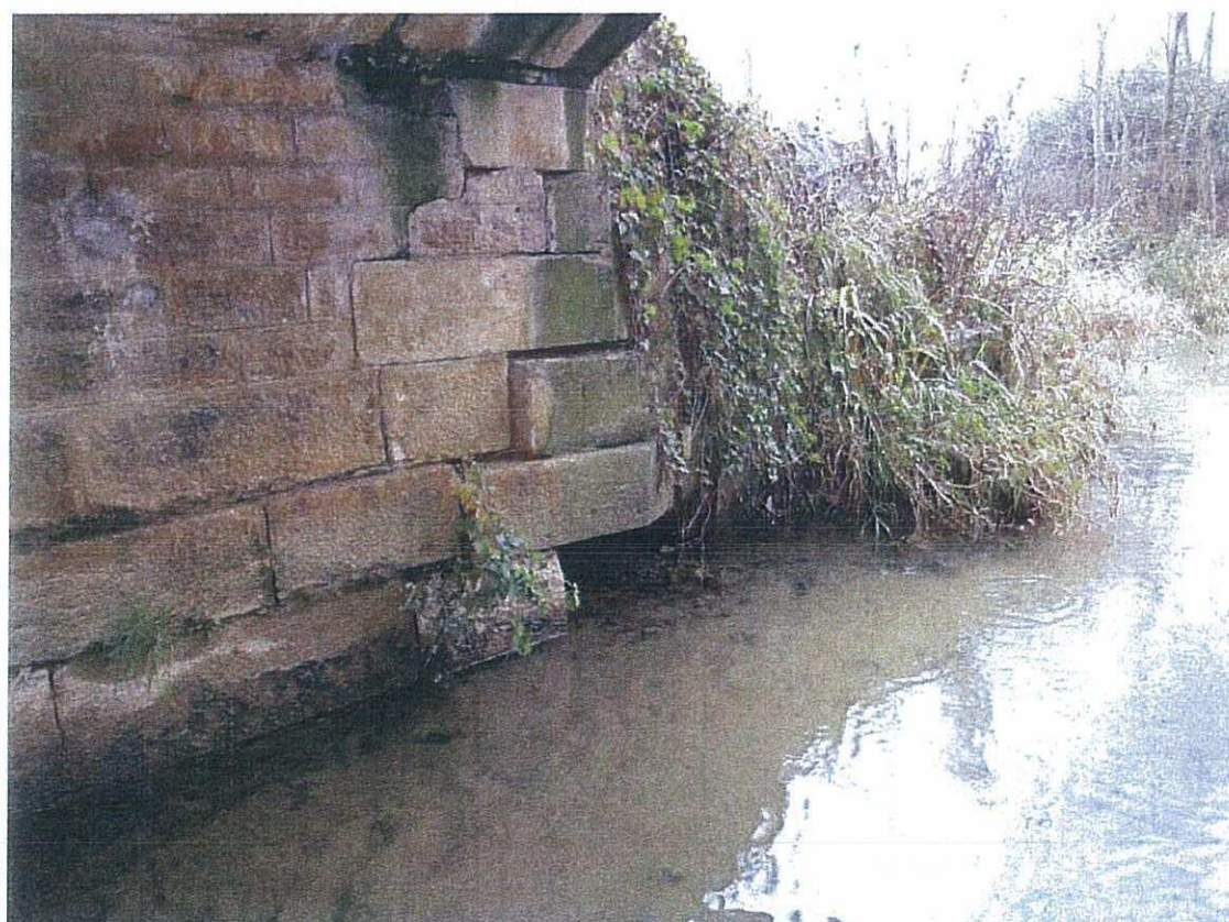
Ph. 32 Evidement en pied de piédroit amont R.D. et déstabilisation de la chaîne d'angle
