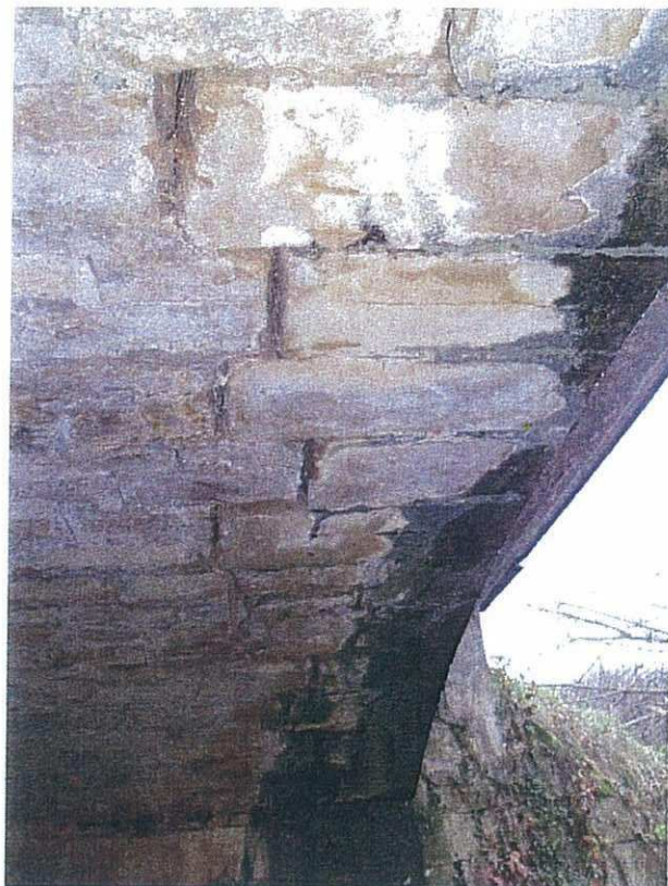
Ph.29 Décollement bandeau amont Côté R.D.
