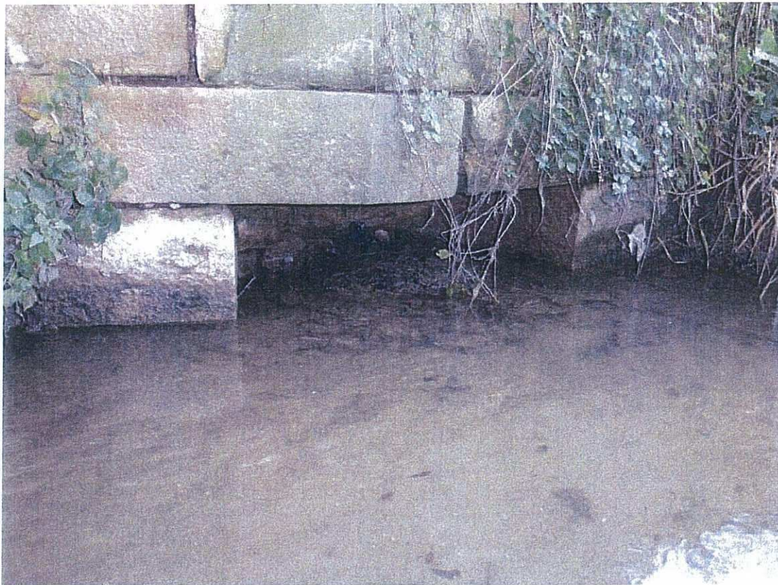
Ph.33 Détail de l'évidement (1.20m x 0.40m x profondeurs 0.80 m)
