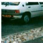
Tranchée d'infiltration
