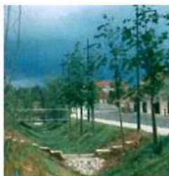
Noues cloisonnées, Parc Bouglione, Corbas
