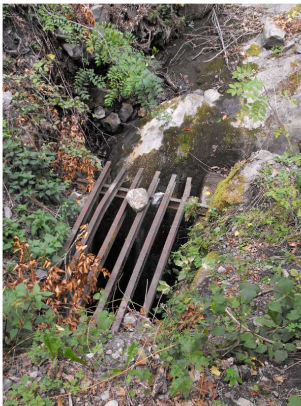
Figure 18: Protection des ouvrages enterrés contre le transport solide
