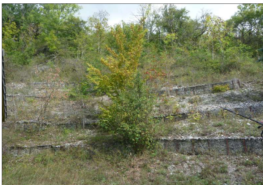
Figure 10: Versant traité en banquettes grillagées végétalisée en amont du Centre de Vacances
