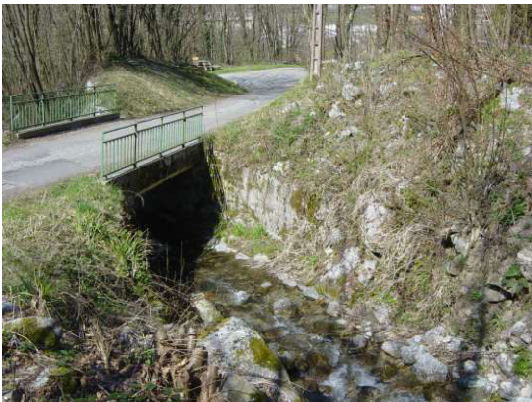
Figure 5 : Point bas dans la berge à supprimer après démolition du pont.
