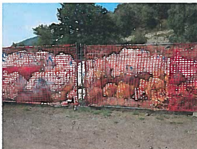
Clôture type HERAS, doublée d'un grillage orange pour plus de visibilité Photo DRYOPTERIS.
