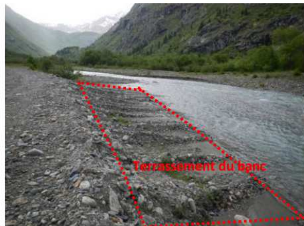
Figure 12 : Terrassement du banc en intrado (2)
