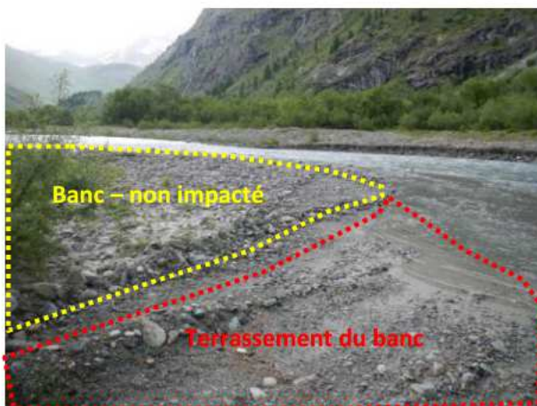
Figure 13 : Terrassement du banc en intrado (3)
