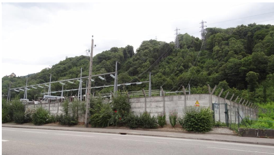
Le poste électrique de Frogès et les lignes 225 000 volts qui l'alimentent
