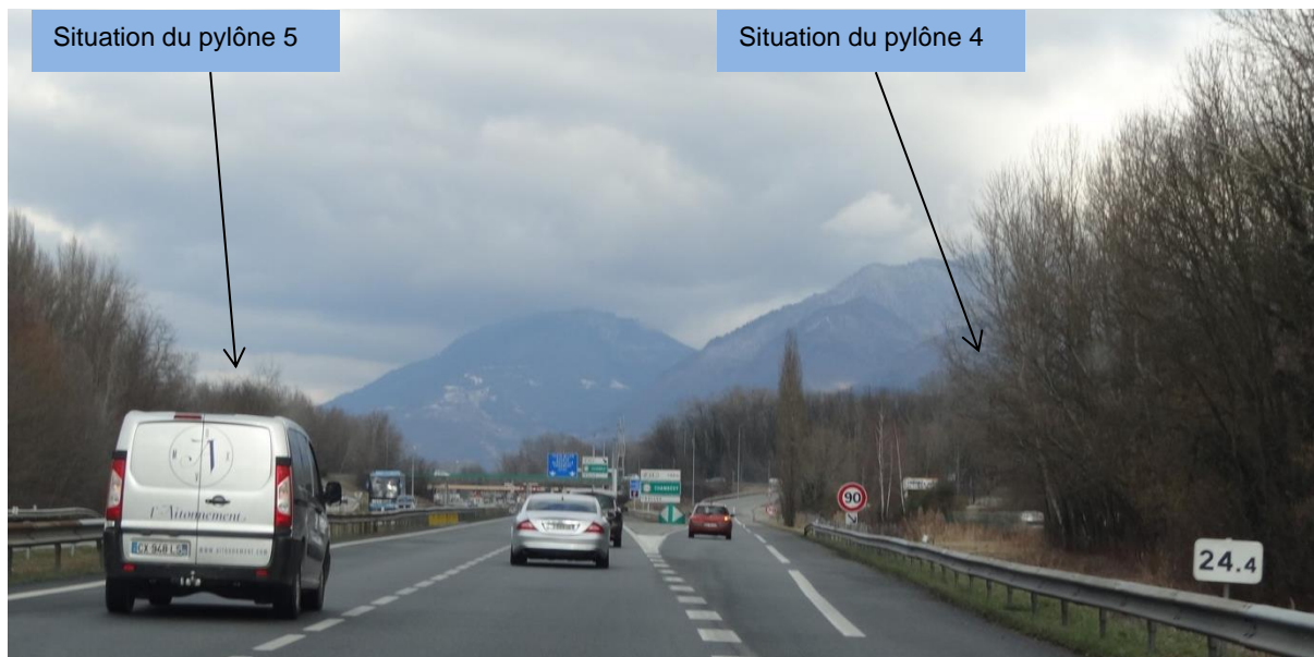
Vue vers les emplacements des pylônes 4 et 5 (masqués par les arbres en quasi-totalité) (Photo 10 février 2018)
