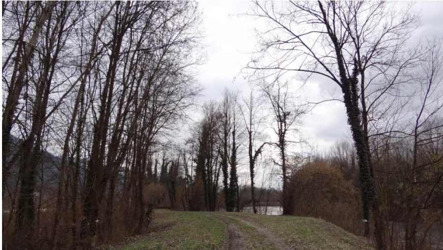
La digue en rive gauche de l'Isère dans le secteur d'implantation du pylône 2
