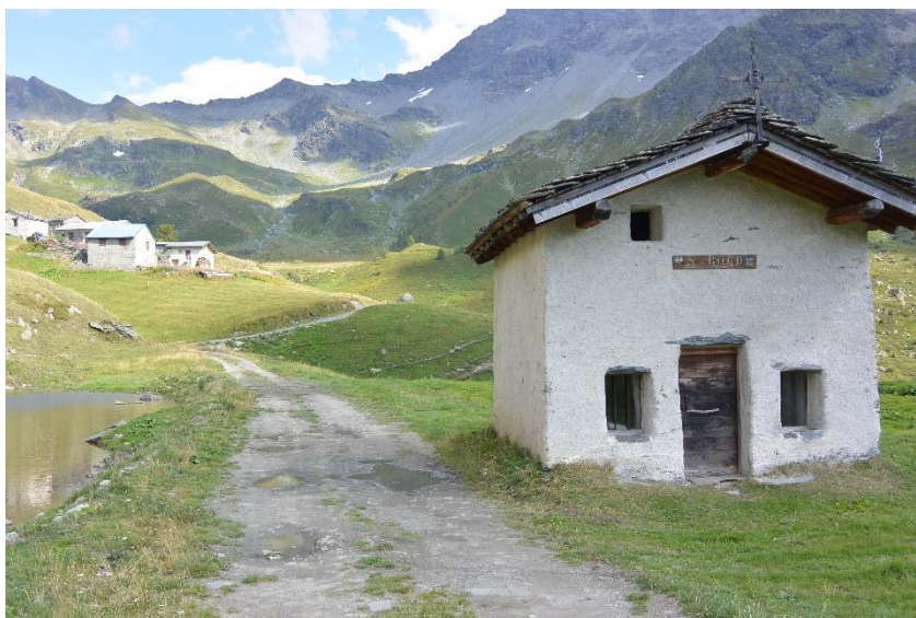
Chapelle et hameau, en bord de piste en direction du refuge de l'Archeboc (septembre 2018)
