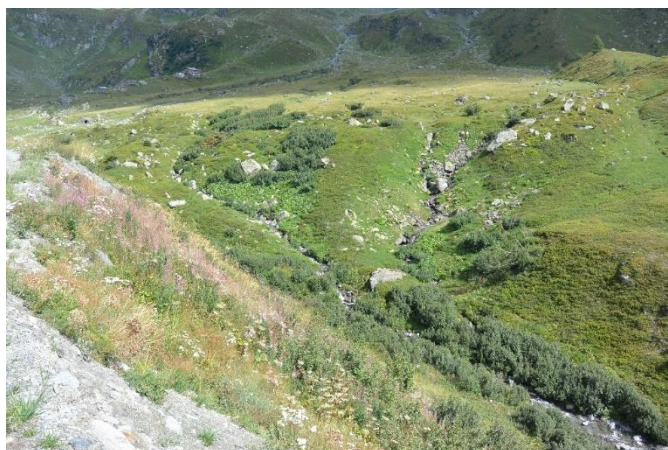
Site de la prise d'eau N°1 et de son dessableur
