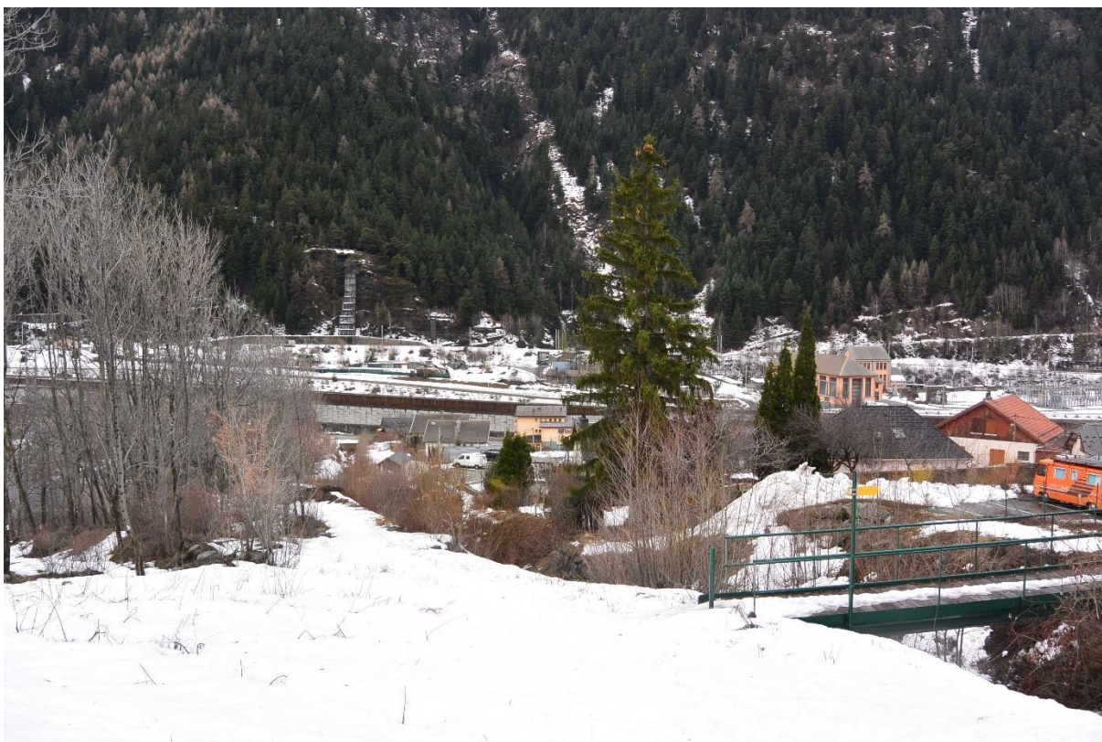
La piste sous laquelle sera enterrée la ligne électrique de raccordement au réseau, au hameau de La Praz. A droite passerelle sur le torrent et premières habitations de la Praz. En arrière-plan l'usine électrique du complexe EDF de Bissorte et infrastructures routières.
