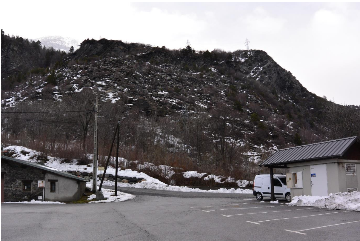
Arrivée de la piste au poste électrique à droite (en haut à gauche forêt domaniale RTM)
