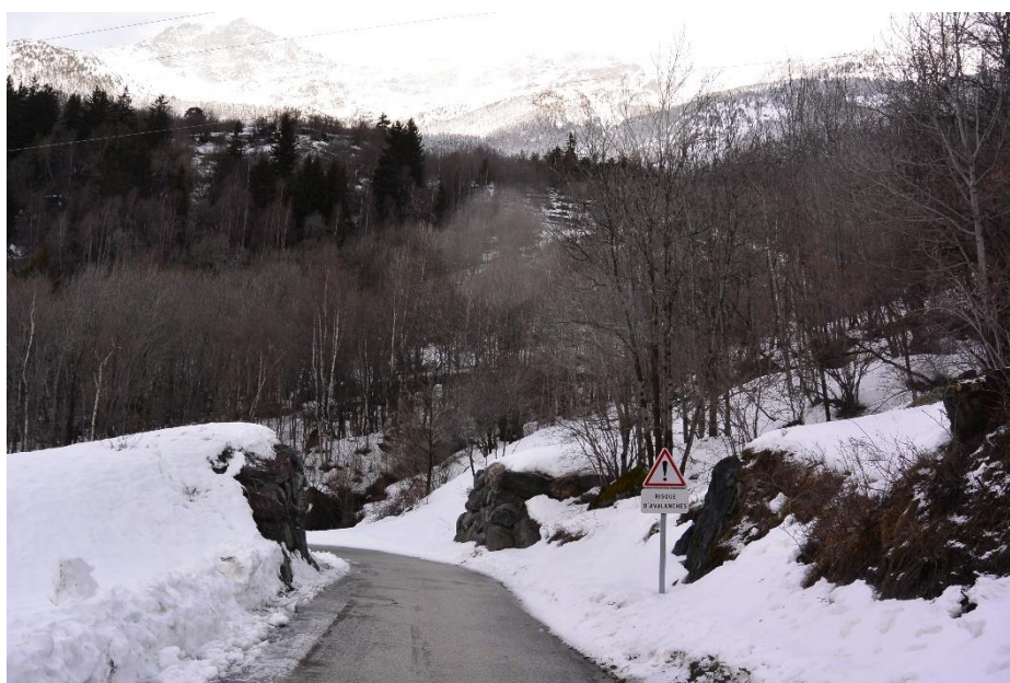
Digues paravalanches RTM avec enrochements
