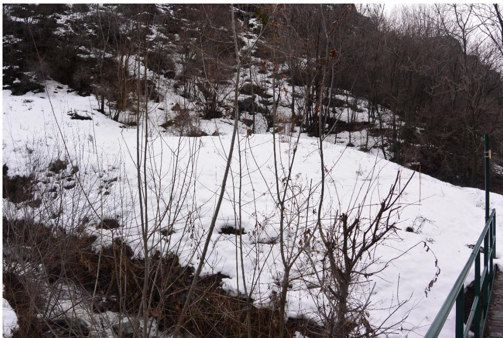
Le site pour implantation du bâtiment de turbinage et transformation, au pied d'un escarpement (invisible des hameaux situés en amont : le Villeret, ...) vu depuis la passerelle
