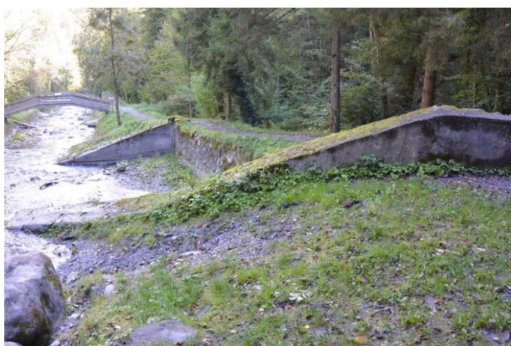
La digue RTM de rive droite et les premiers seuils, avec en arrière-plan la passerelle qui donne accès à la digue de rive droite depuis le sentier d'interprétation situé en rive gauche (point coté 564 m de la carte précédente)
