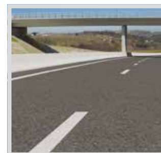
MARQUAGE AU SOL
