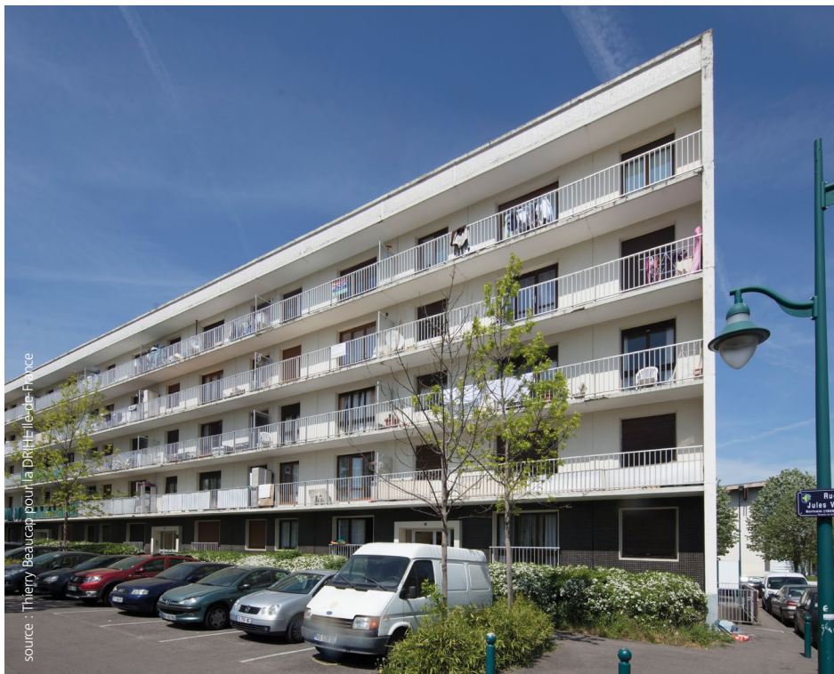
Les Côtes de Seine avant les travaux
