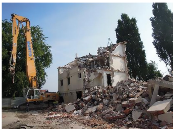
Démolition du bâtiment C « les Clématites »
