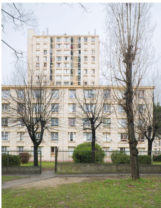
La copropriété du Petit Bard à Montpellier : états des lieux en 2009 avant le début de l'opération de réhabilitation. Source : Anah/Éric Sempé
