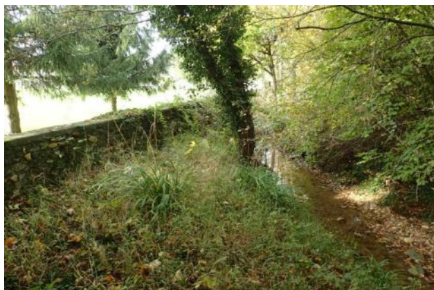
Figure 12 : Présence d'un mur dauphinois en rive gauche limitant et contraignant les débordements sur cette berge mais perméable aux écoulements
