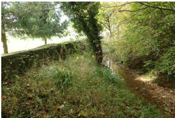
Figure 3 : Mur dauphinois en rive gauche limitant et contraignant les débordements
