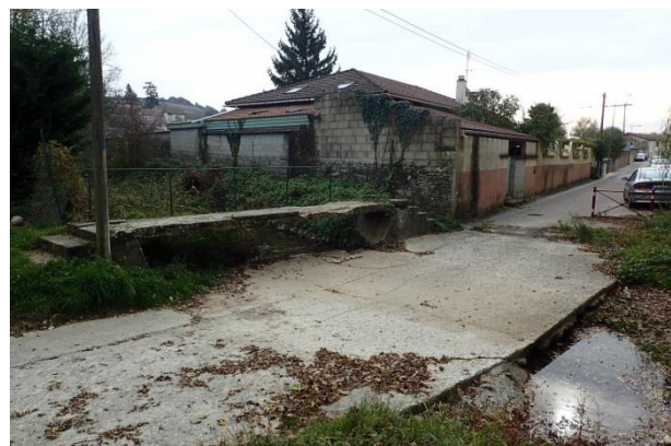
Figure 50 : Photo d'ensemble de la passerelle et du passage à gué en direction du sud
