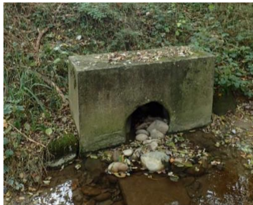
Figure 29 : Réseau EP en rive gauche sur l'amont du linéaire d'étude
