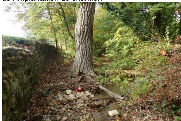
Figure 23 : Présence d'un arbre de gros diamètre (> 70 cm) au milieu du lit actuel
