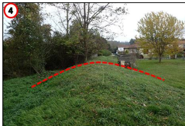
Berge rive gauche et présence d'un merlon de terre en haut de berge (BURGEAP 11-2016)
