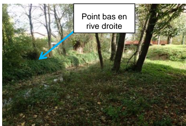
Figure 11 : Un point bas est présent en aval rive droite du pont de la RD8 (à gauche sur la photo)
