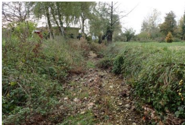
Figure 31 : Merlon de terre en haut de berge
