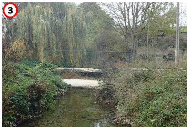
Passage et passerelle piétonne en travers de la Vésonne (vue vers l'amont - BURGEAP 11- 2016)
