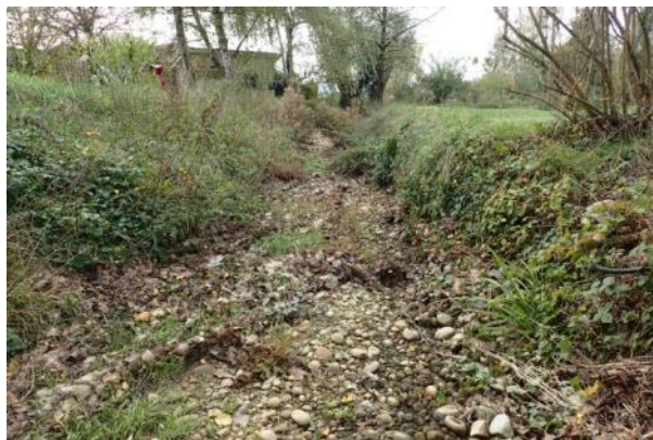
Figure 26 : Secteur en assec en aval du passage à gué le jour de la visite sur site (03/11/2016).
