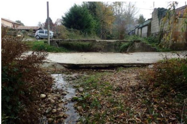
Figure 28 : Passage à gué et passerelle piétonne sur la Vésonne
