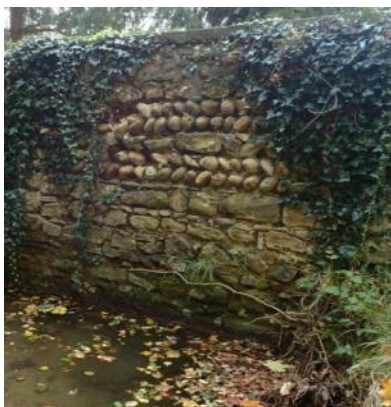
Figure 30 : Mur dauphinois en galets roulés en rive gauche
