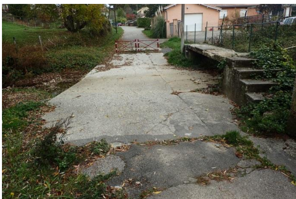
Figure 49 : Photo de la passerelle et des escaliers vue depuis le chemin du moulin en direction du nord
