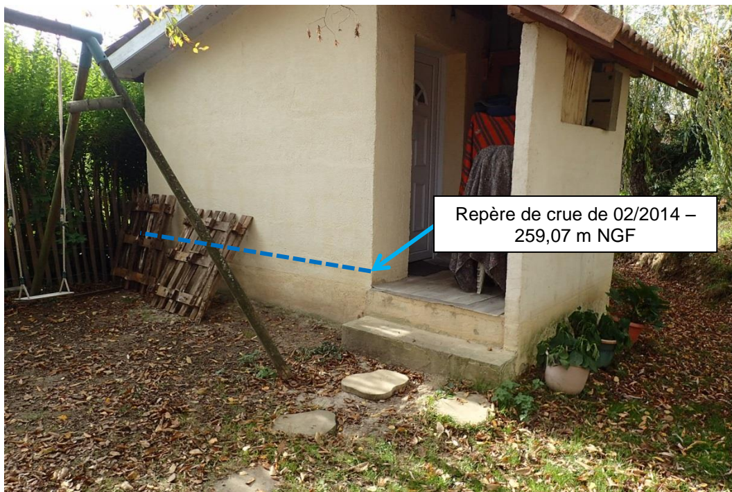
Figure 4 : Repère de crue sur la cabane de jardin dans la parcelle n°379 en rive gauche de la Vésonne
