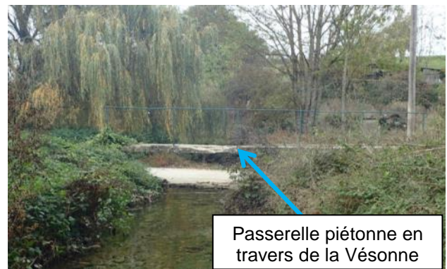
Figure 4 : Passerelle piétonne et passage à gué présents dans le lit de la Vésonne
