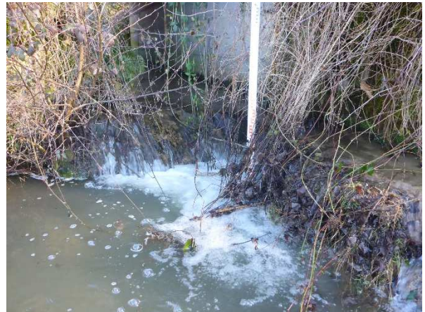
Chute en aval de l'ouvrage (0,3 m en écoulement moyen)
