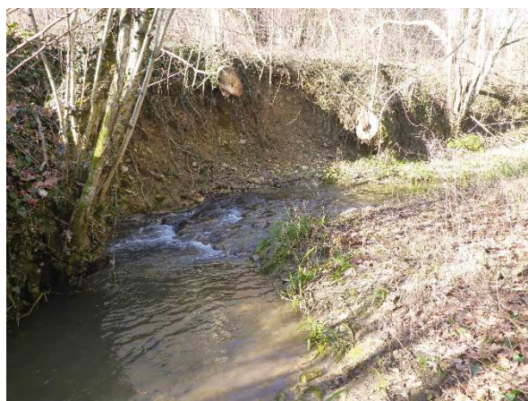
Érosion de berge en extrados
