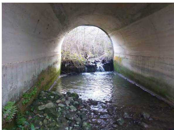
Dans l'ouvrage depuis l'aval (embâcle générant une chute de 0,6 m sur section amont)
