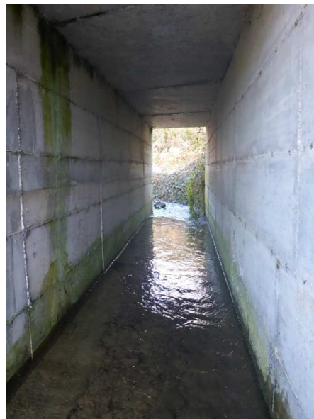
Dans l'ouvrage depuis l'aval (radier calcifié)
