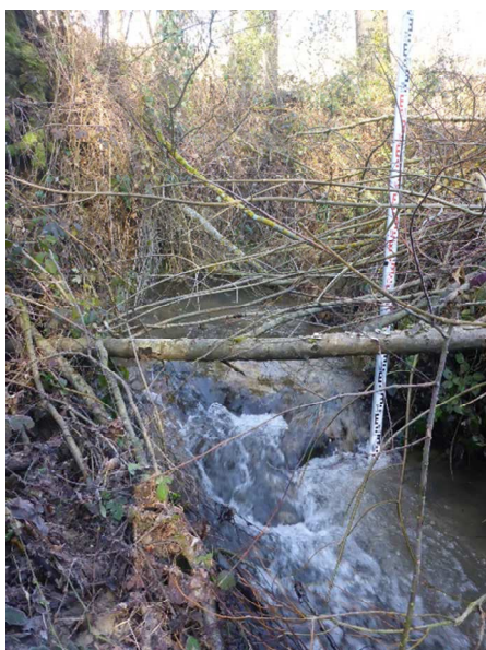
Petit seuil en enrochements en aval du pont 2 (avec rémanents de coupes de peupliers en travers de la section)
