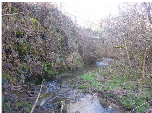
Protection rive gauche en enrochements
