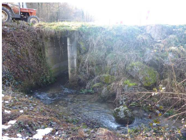
Section amont (coude prononcé et enrochements déstabilisés en rive gauche)
