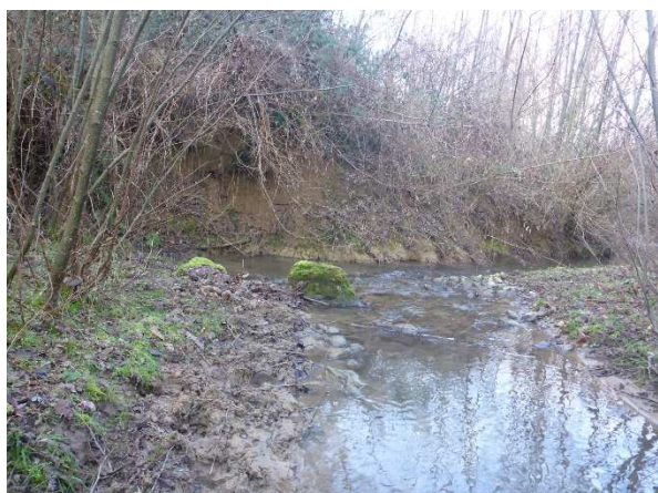
Érosion du versant rive gauche en partie aval
