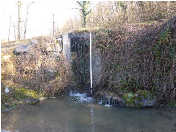
Section aval avec enrochements sur talus de la route
