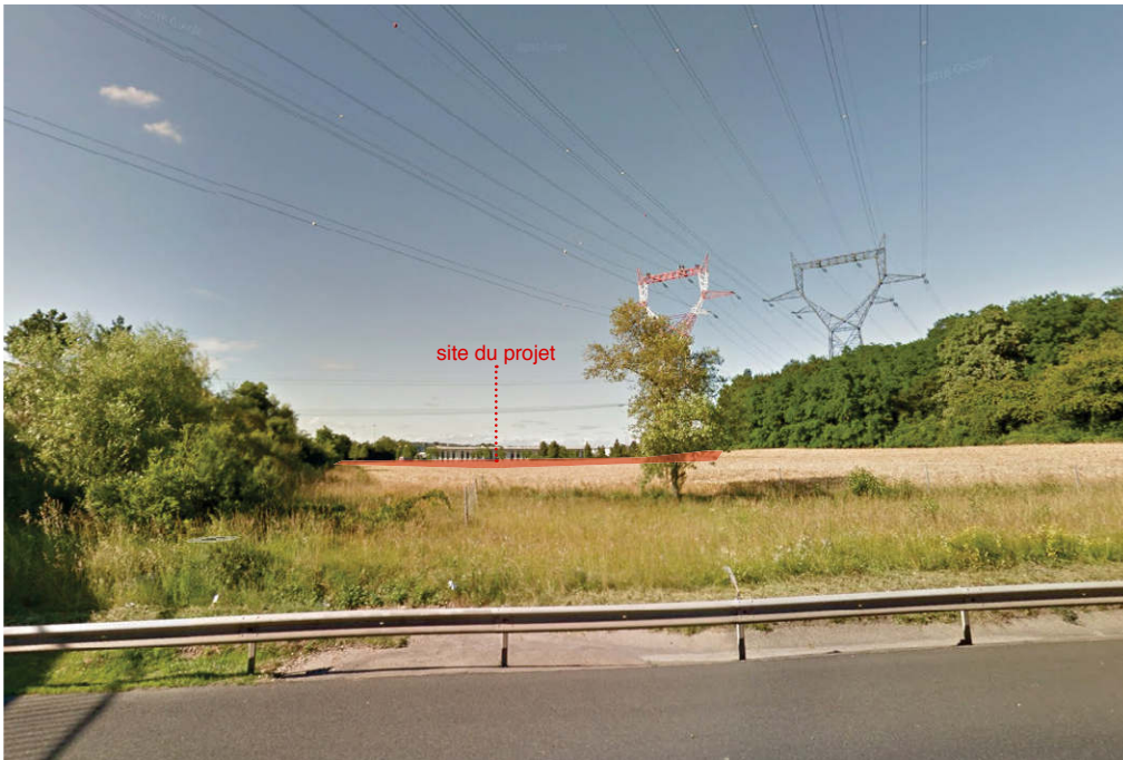
2. Vue prise depuis l'A 43.
