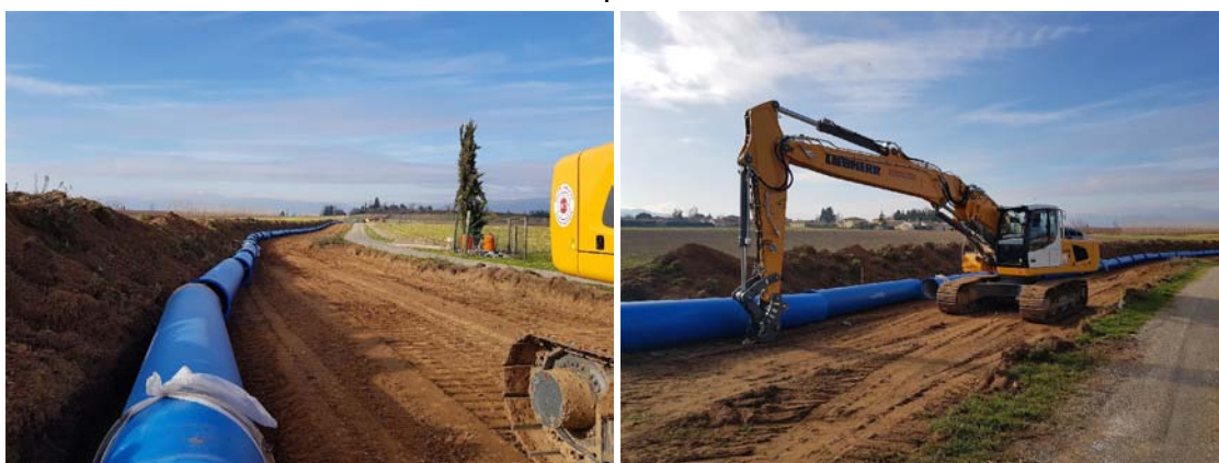
Exemple de chantier de pose (phase initiale, gros diamètre, parcelles agricoles) dans la Drôme © CAEAU
