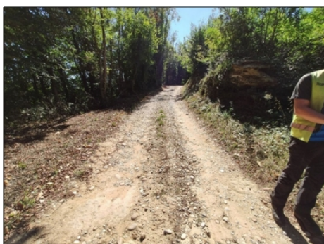
Exemple d'emprise réduite, dans un chemin forestier sans emprise supplémentaire, aspect après travaux. © CAEAU
