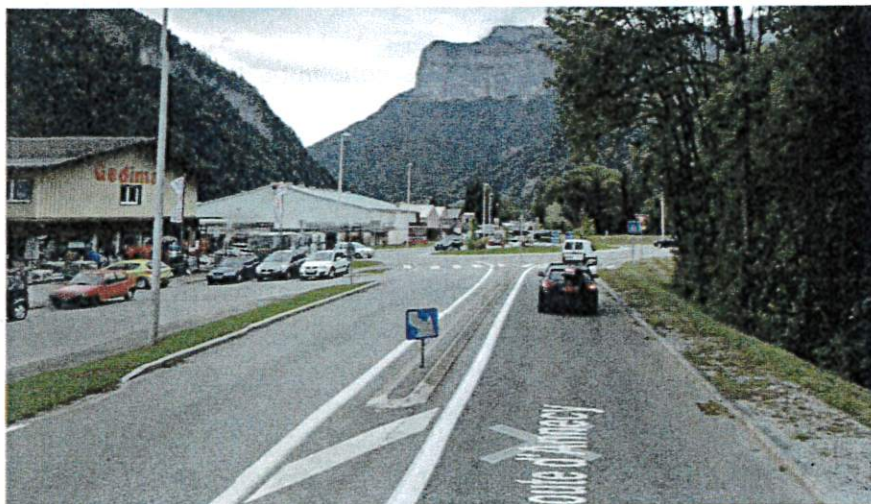
Le carrefour giratoire existant entre la rue de Balmette et la RD909
