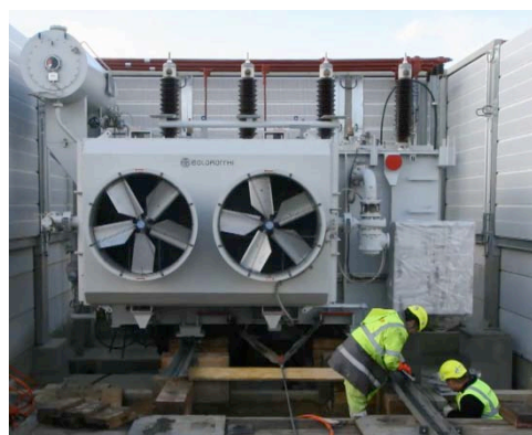
Transformateur de puissance en cours d'installation
