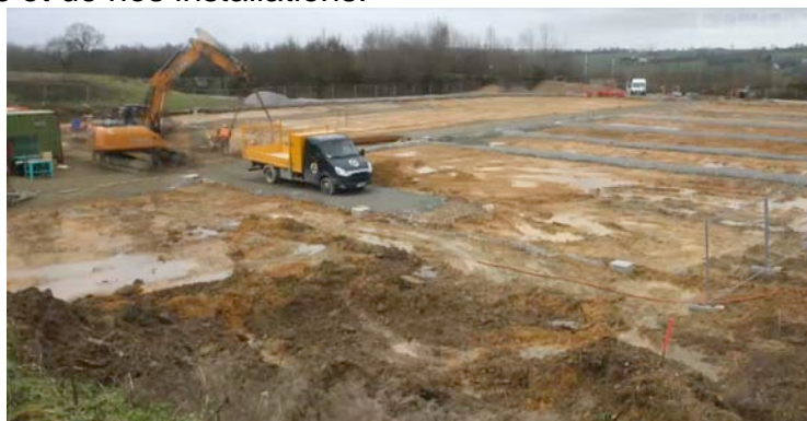
Exemple de réalisation de la plateforme (poste neuf)
