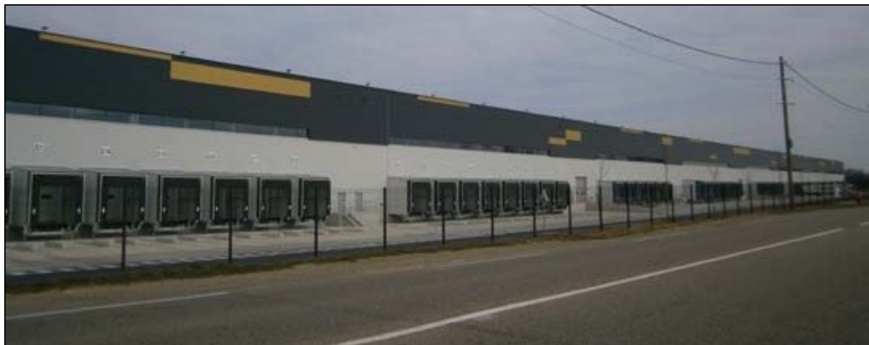
Constructions aménagées sur la plateforme logistique du Buchet
