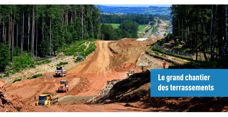
Ces derniers mois ont été marqués par une étape importante dans l'avancement du chantier, avec les travaux des terrassements sur la section Déviation de Sansac-de-Marmiesse depuis le Pas du Laurent jusqu'au rond-point de La Poudrière. Le tracé long de 7,5 km nécessite également la construction d'ouvrages connexes parmi lesquels 19 ouvrages hydrauliques, 4 bassins de rétention ainsi que des passages agricoles, piéton et pour la grande faune.
