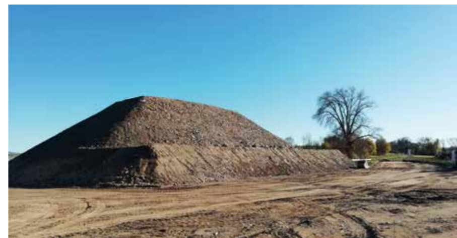
Zone de pré chargement : tassement contrôlé de 20 cm du terrain naturel
