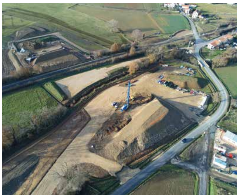
Le périmètre actuel de la zone de travaux
