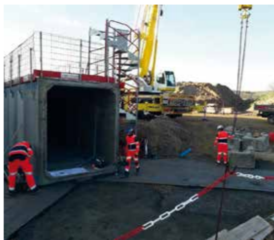
Pose des buses assurant l'écoulement des eaux naturelles
