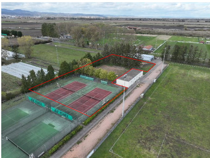
Photographie C : vue éloignée du site depuis le sud-est (07/11/2023)
