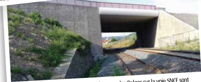
Les travaux de doublement du pont de l'avenue des Belges sur la voie SNCF sont terminés depuis juin 2017. Le réaménagement de l'avenue des Belges, assuré par la Communauté d'agglomération du Puy-en-Velay, est effectif depuis décembre 2017.
