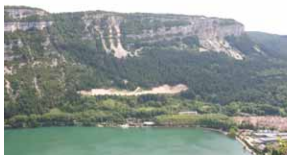
barres rocheuses de la rive Nord, et ouvrage de protection
